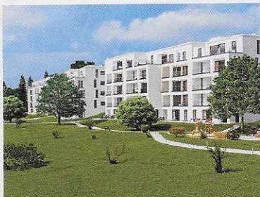
Kloten In der Flughafengemeinde wird die Überbauung «Neubrunnenpark» hochgezogen. Sie umfasst 80 Eigentumswohnungen (siehe Projekt 3 auf Seite 68).
