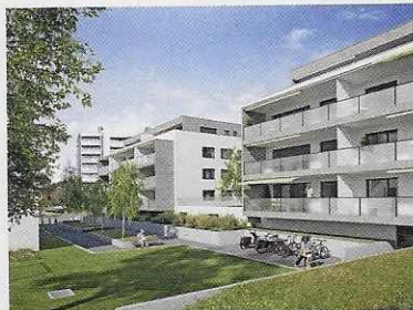
Schliern Im Könizer Ortsteil Schliern werden drei Mehrfamilienhäuser mit 33 Eigentumswohnungen fertig gestellt (siehe Projekt 4 auf Seite 64).
