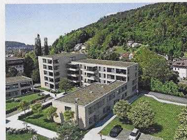
Liestal Mit dem Grienmattpark im Baselbieter Hauptort werden 25 Eigentumswohnungen erstellt (siehe Projekt 5 auf Seite 72).
